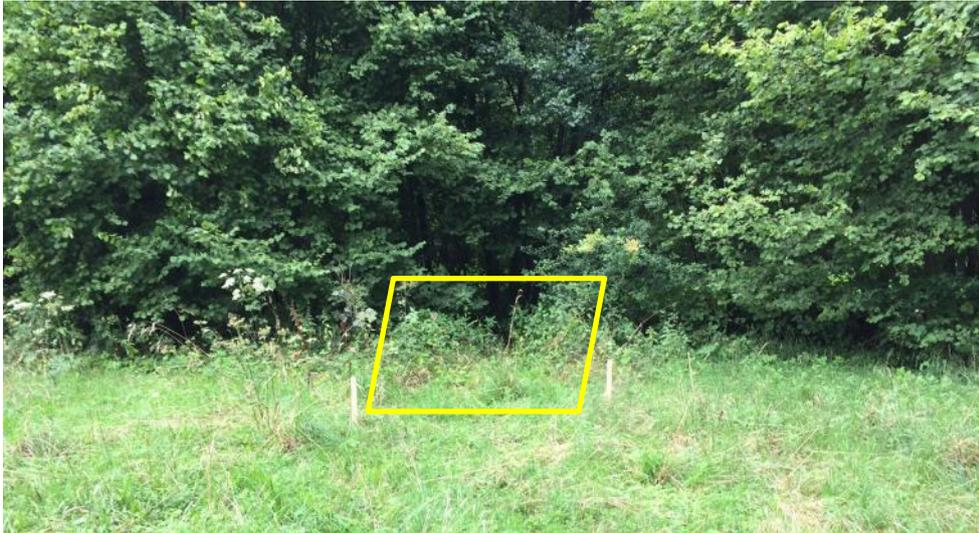
Foto 5: Holzpfähle im Gelände als Endbereich für die Uferabflachung bzw. Flutmulde (Foto: Hr. Jacobi, UWB Rhein-Sieg-Kreis)
