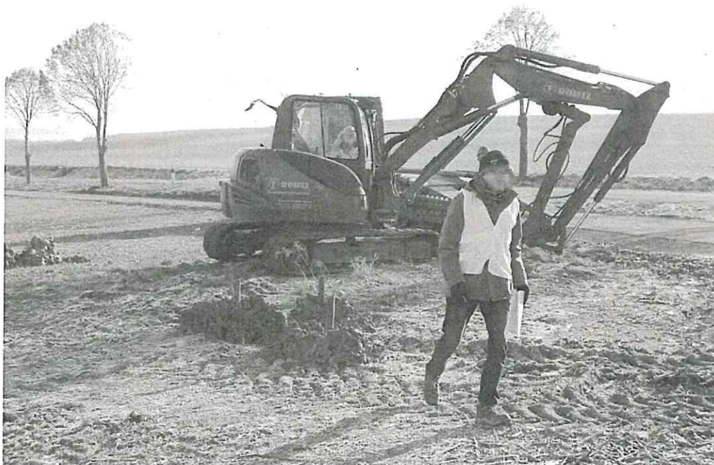
Abb. 1: Minibagger mit Kettenantrieb und Schneckenbohrvorsatz und beispielhaften Bohrlöchern
