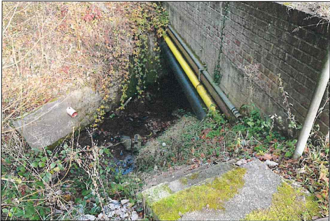
Foto 3: Ohbachabschnitt mit Treppenanlage am Durchlass an der L 144
