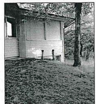
Sanierungsbereich Abwasserkanal / Schachtlage
