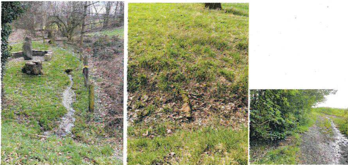
(Abb.1: Wasserlauf am „Dreiherrenstein“) (Abb.2: Drainage, Entwässerung des feuchten Flurstück 187/69)
