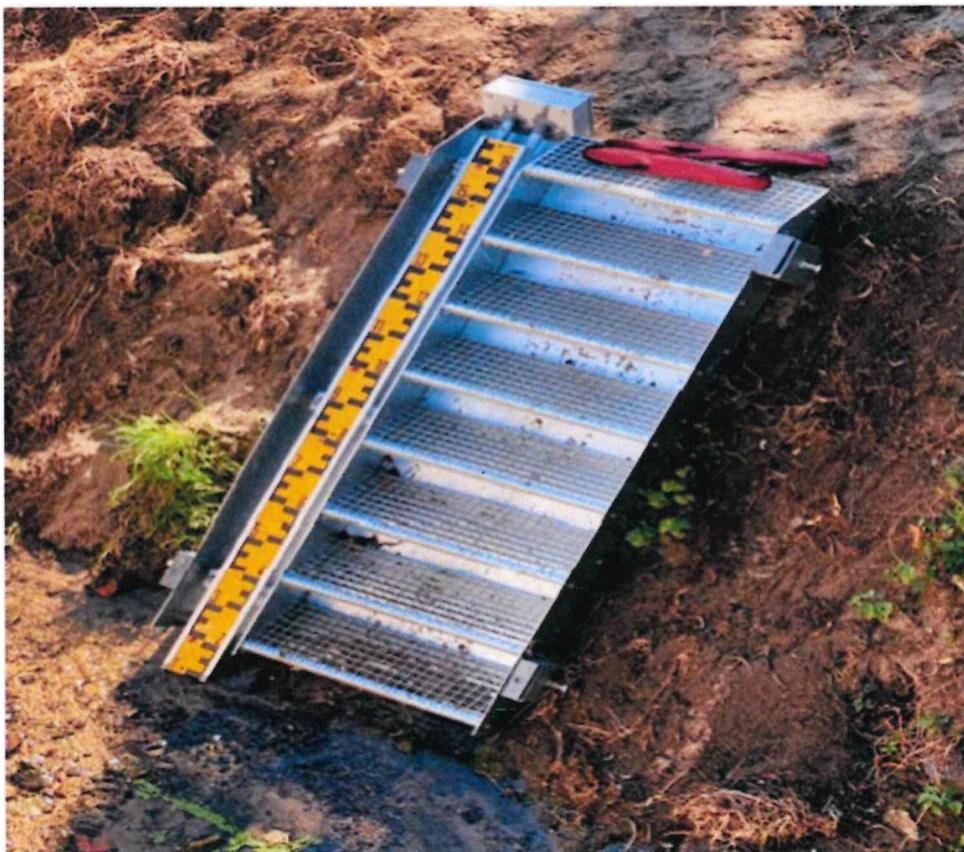
Beispielfoto Doppelwangenstahlterpe mit Pegellattenwanne und Pegellatte
