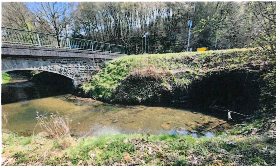
Abbildung 8: Bestandssituation, links im Bild das Bestandsbauwerk der Hennefer Straße, rechts das zu tauschende BW 26; nicht zu sehen ist die im Rücken des Fotografis befindliche Hochwasserschutz-Spundwand.
