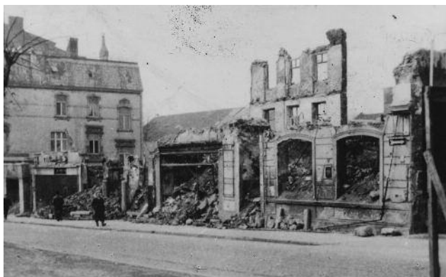
Zerstörungen am oberen Markt in Siegburg nach dem Luftangriff vom 28. Dezember 1944
